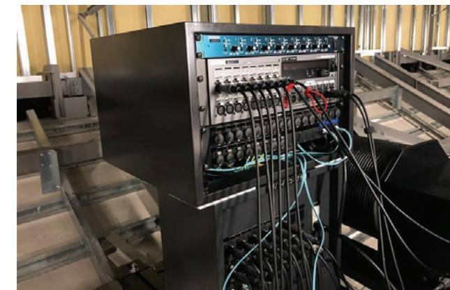
電動吊マイク装置近くのマイクアンプ
