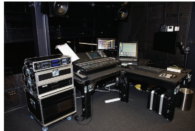
コントロールギャラリーの音響機器
