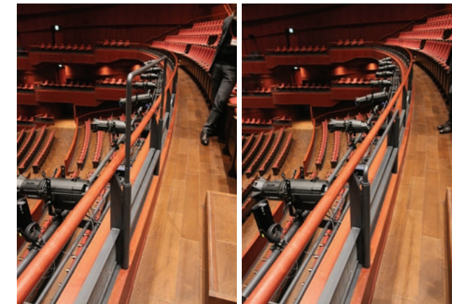
伸縮式の縦通路正面手摺
