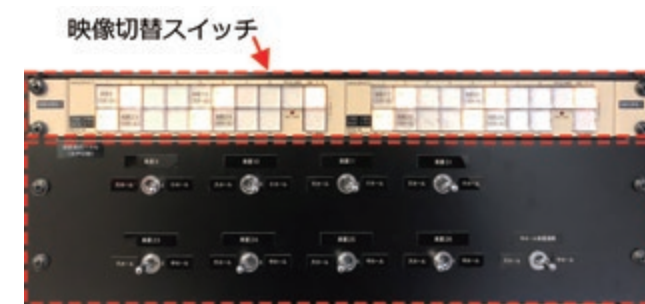
写真9 管理事務室の兼用楽屋用の映像、音声切替スイッチ
