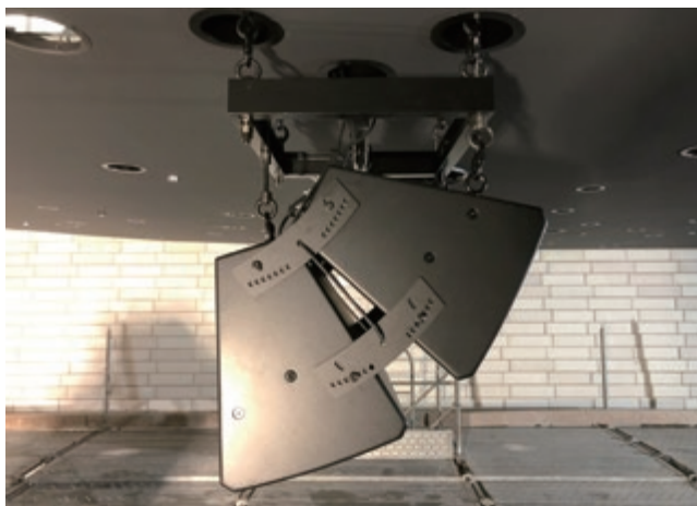
写真6 小ホールプロセニアムスピーカー施工状況
