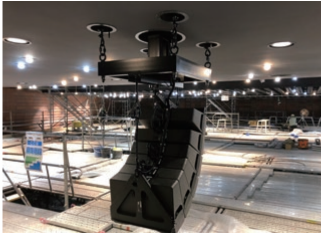
写真5 中ホールプロセニアムスピーカー施工状況
