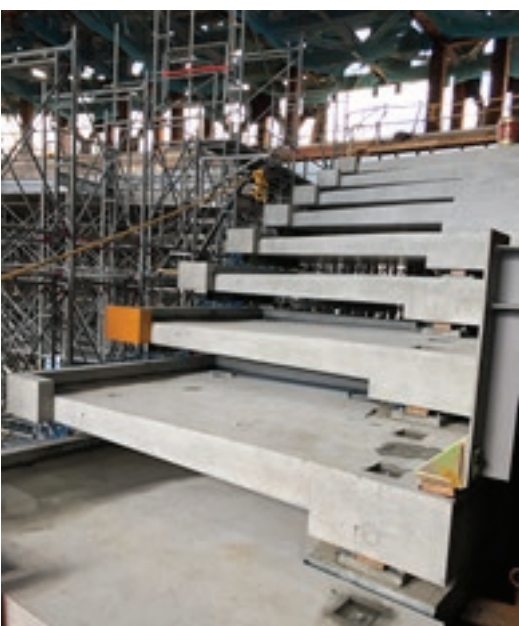
大ホールサイドバルコニー床のPC板（最下段のPC板根元の下に防振ゴムが見える）
