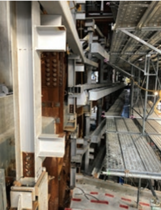
大ホールレンガ壁下地鉄骨（白い垂直部材が浮間柱）
