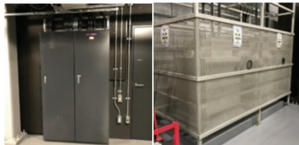
舞台下手音響電源分電盤とノイズカットトランス
