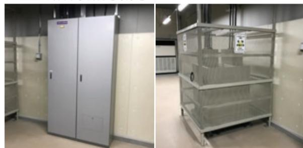
アンプ室音響電源分電盤とノイズカットトランス
