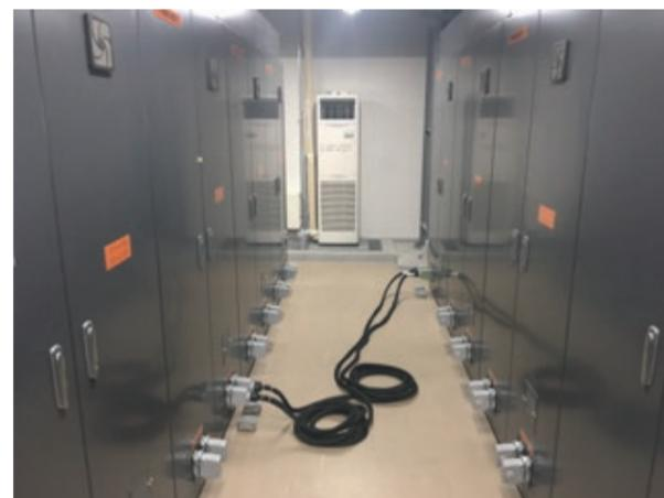
制御盤バックアップケーブル接続状態
